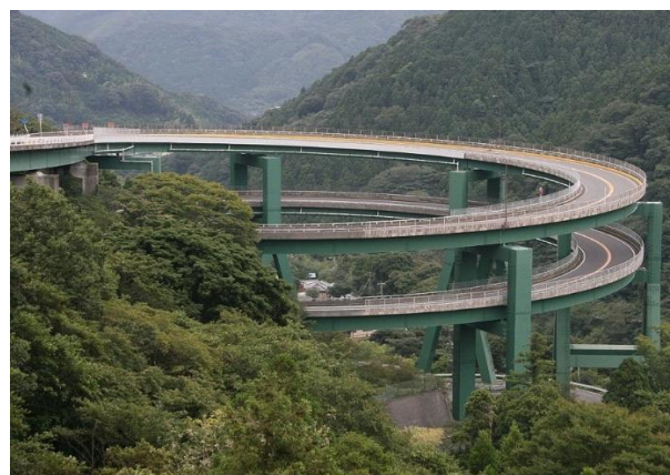
Рис. 1.6. Схема использования возможности прокатывания нагрузок по спиральным пандусам
